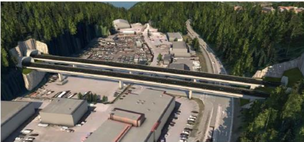
Figur 16 Skjelsvikdalbruene, sett mot vest
